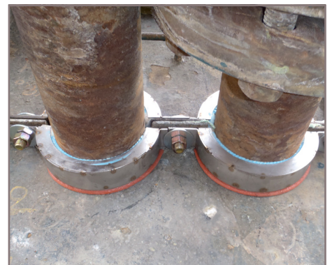
Techeat Expansion® C.54 • Fixation 1 point : casing du four • Etanchéité par glissement
